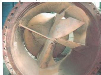
Рис. 2. Конусный затвор водовыпускного сооружения.
