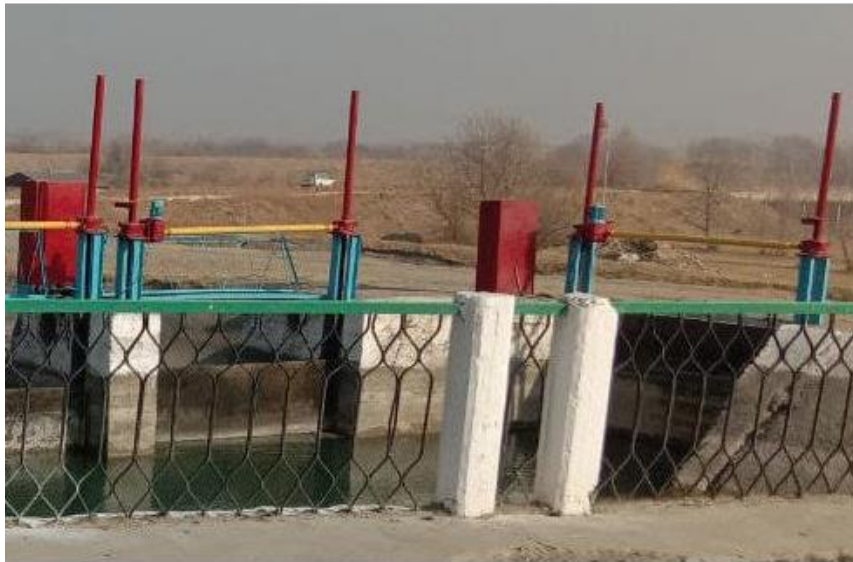
Рис.1. Затворы Джизакского водохранилища
